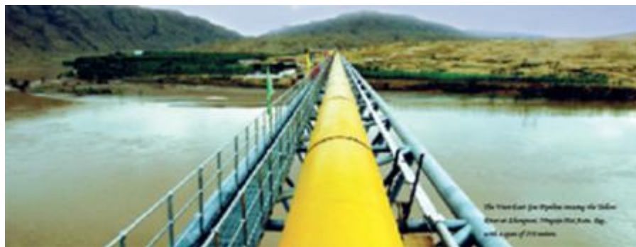
FOTO 1: Oleoducto OESTE-ESTE cruzando el Río Amarillo
